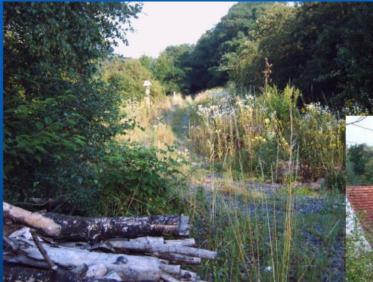
Die stillgelegte Trasse der Kanonenbahn
